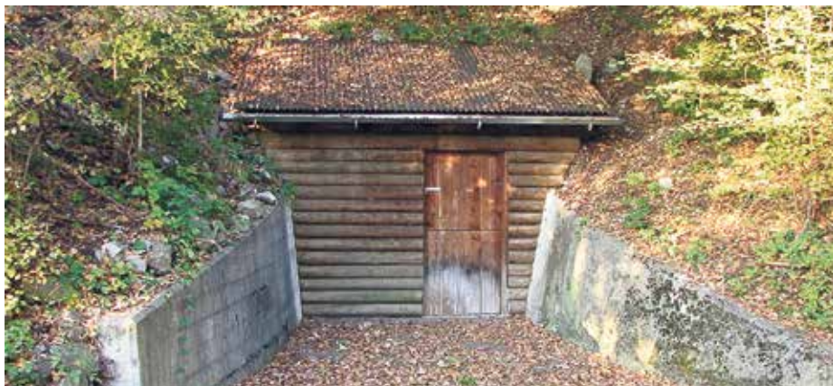
L'entrata camuffata della galleria della Goldey, nell'Oberland bernese.
