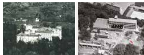
1961, al posto del prestigioso Castello di Trevano, demolito da 230 cariche di esplosivo, fu eretto un complesso scolastico in cemento (Foto Supsi).
