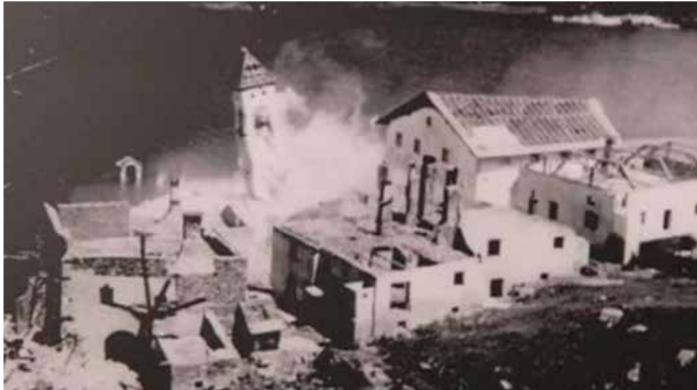
Curon durante la sua demolizione con le mine, il 23 luglio 1950, per la costruzione di una diga voluta dalla Montecatini (futura Montedison). Foto tratta dal videoweb "Curon prima e dopo la diga".
